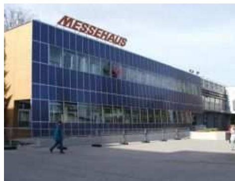
Pevně umístěné panely na fasádě s jižní orientací - roční produkce cca 75 kWh/m 2 (68 %)
