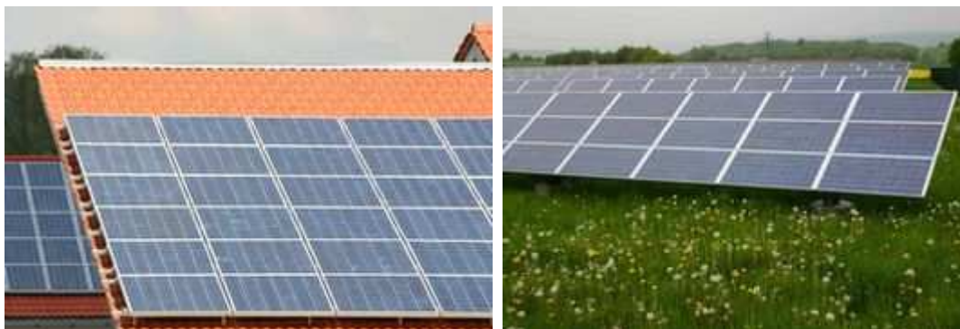
Pevně umístěné panely - roční produkce cca 110 kWh/m 2 (100%)
