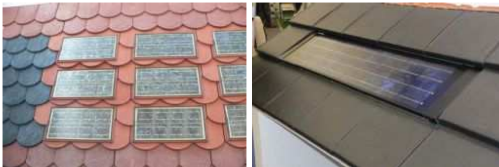
Fotovoltaické panely integrované do krytiny různým způsobem.
