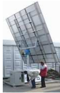
Panely s natáčením ve dvou osách - roční produkce cca 150 kWh/m 2 (136%)
