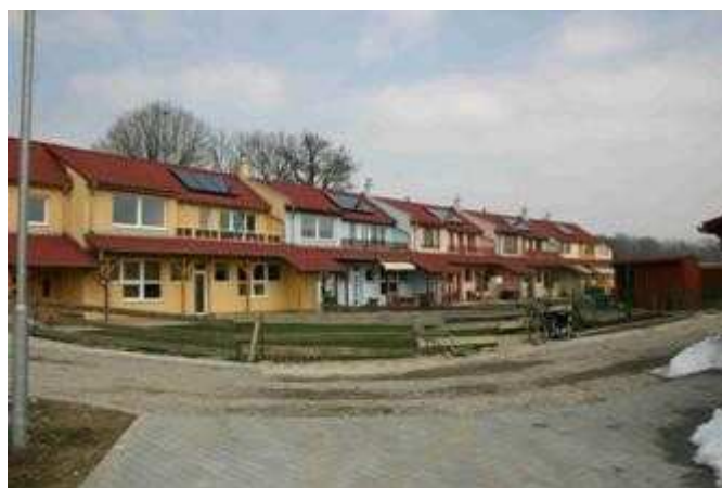
Solární systém jako standardní součást řadové výstavby
