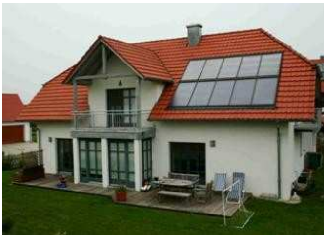
Solární systém na současném rodinném domě
