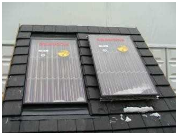
Kolektor integrovaný do střechy a uložený nad střešní krytinou
