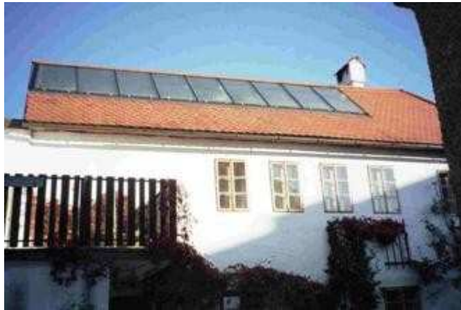
Solární systém na domě ze 16 století
